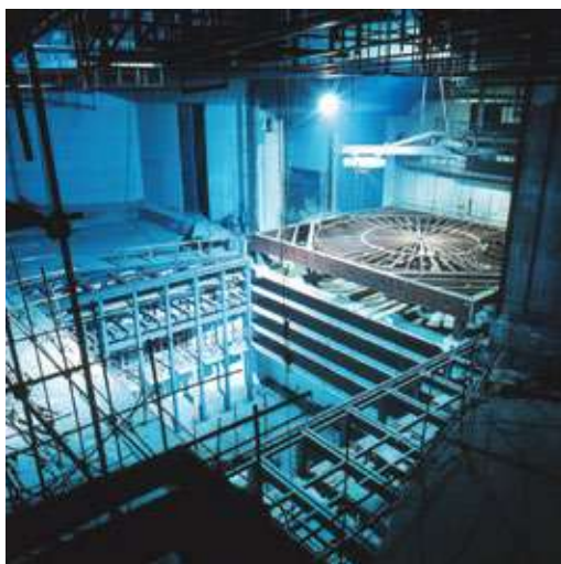
Stavba nového divadla v Prešove
